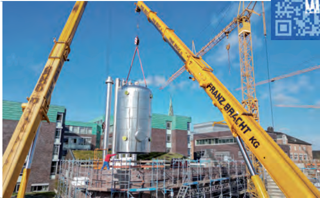
In der neuen Technikzentrale werden Wärmepumpen, Speicher und Regeltechnik installiert.
