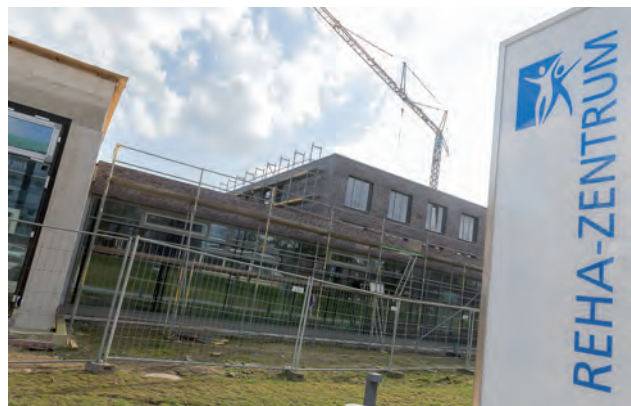
Im Neubau Reha C schreitet der Innenausbau voran.
