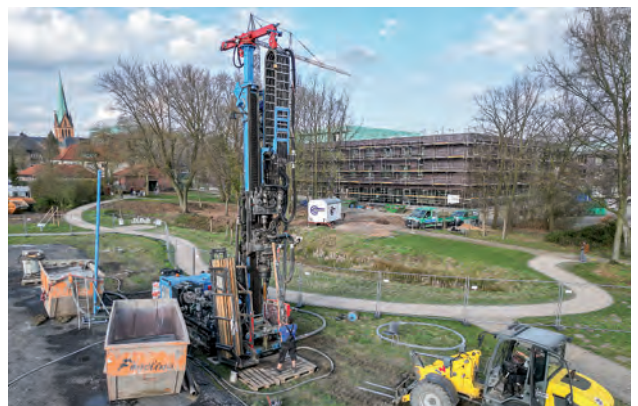
Nachhaltige Energieversorgung: Geothermiebohrungen auf dem Campus.
