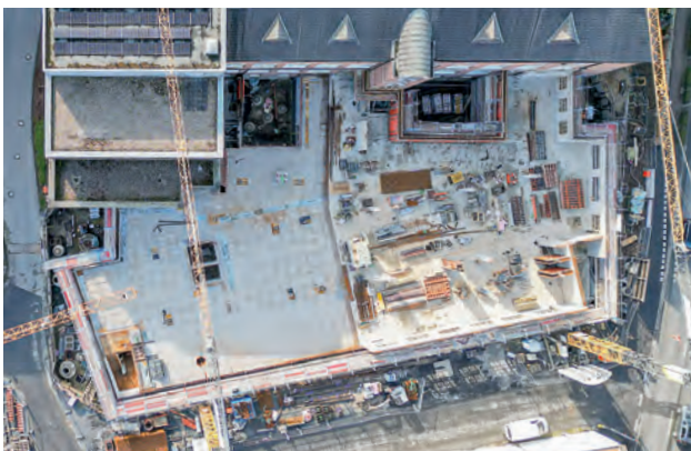
Der Bau des neuen OP- und Funktionsgebäudes wächst in die Höhe.
