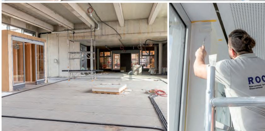
Die Arbeiten an Reha C laufen planmäßig – die Inbetriebnahme ist für November vorgesehen.
