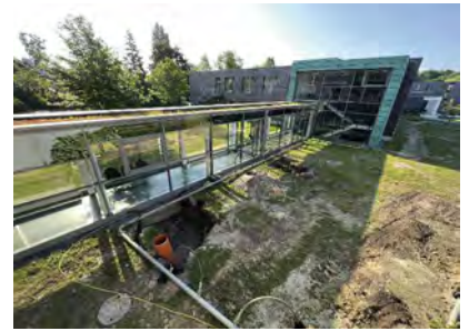
Damit die Erdwärme in der Energiezentrale in verwertbare Energie umgewandelt werden kann, werden bereits die Gräben für die neuen Versorgungsleitungen vorbereitet.
