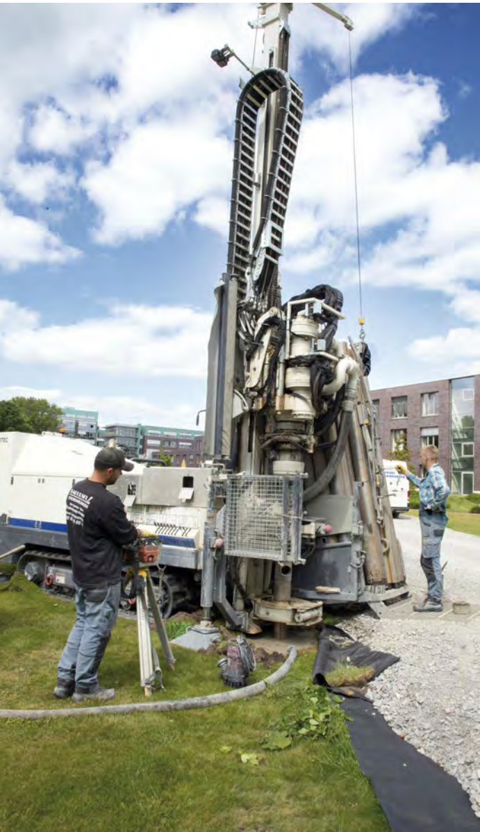
Großer Aufwand für ein einziges Bohrloch: Zwei Tage wurden benötigt, um die Probebohrung in 150 Meter Tiefe zu treiben und den Sondenschlauch für die Erdwärmetechnologie einzubetonieren.
